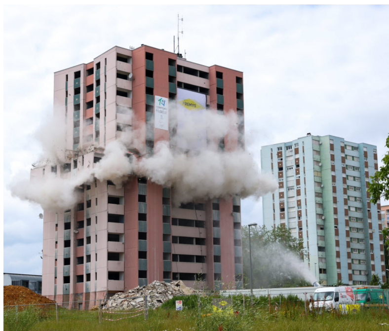
Démolition d'une tour 3 rue de Dorey – 01/07/2021 © Territoire Habitat
